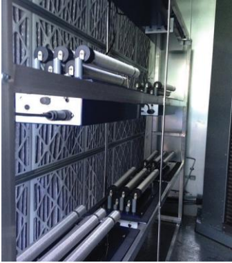
İyonlaştırıcıların herhangi bir klima santraline montajı için sürgülü raf kurulumu.
