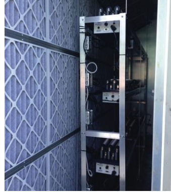
İyonlaştırıcıların herhangi bir klima santraline montajı için sürgülü raf kurulumu.
